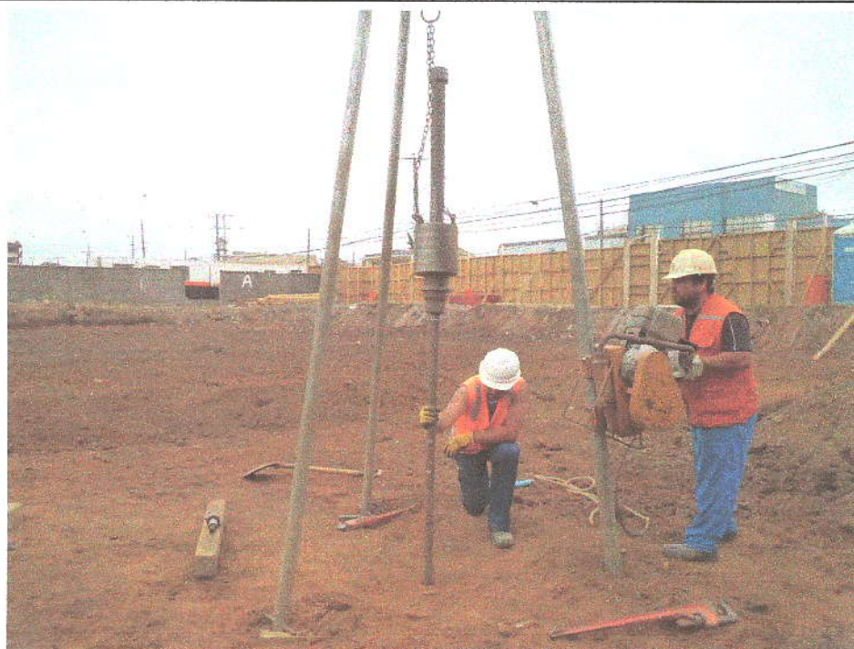
FOTOGRAFIA 16: EJECUCIÓN DE SONDAJE N°3
