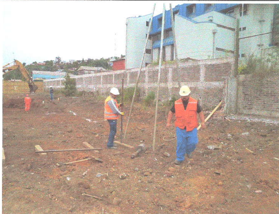
FOTOGRAFIA 7: EJECUCIÓN DE SONDAJE N°2
