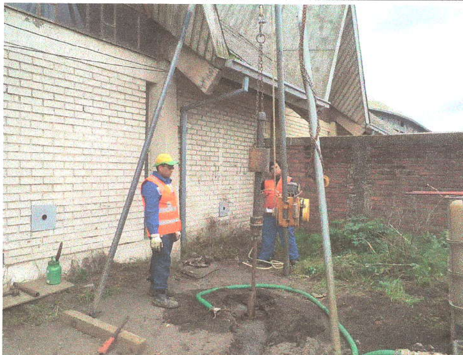
FOTOGRAFIA 3: EJECUCIÓN DE SONDAJE N°1
