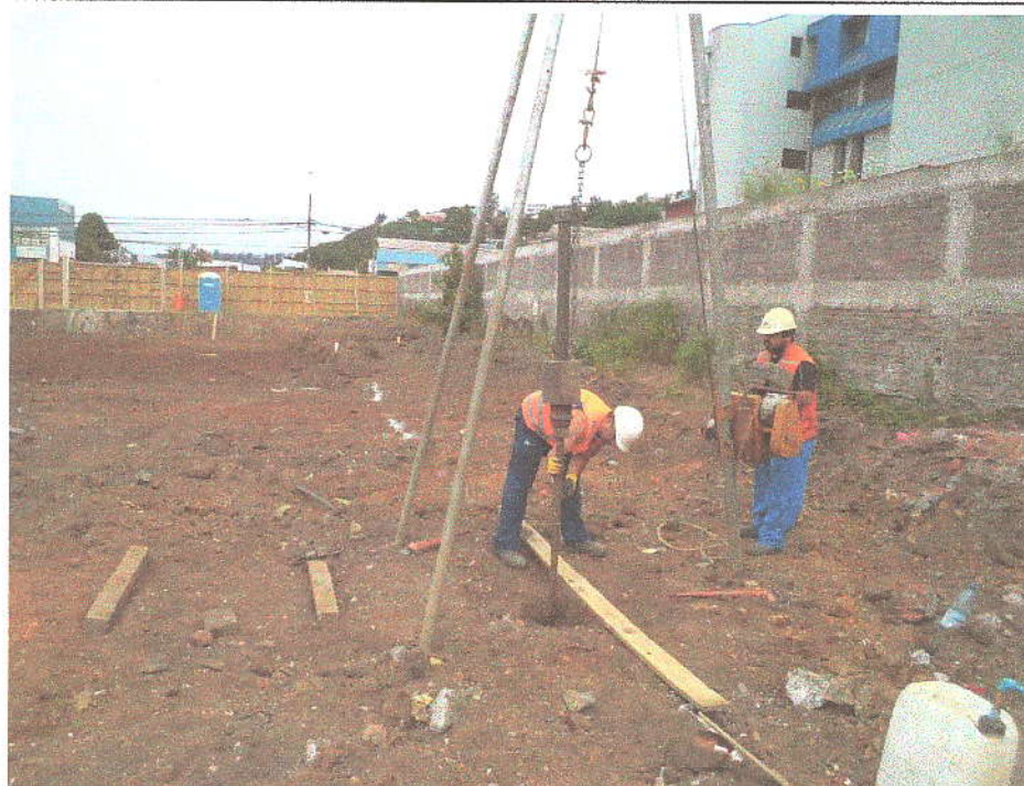
FOTOGRAFIA 9: EJECUCIÓN DE SONDAJE N°2
