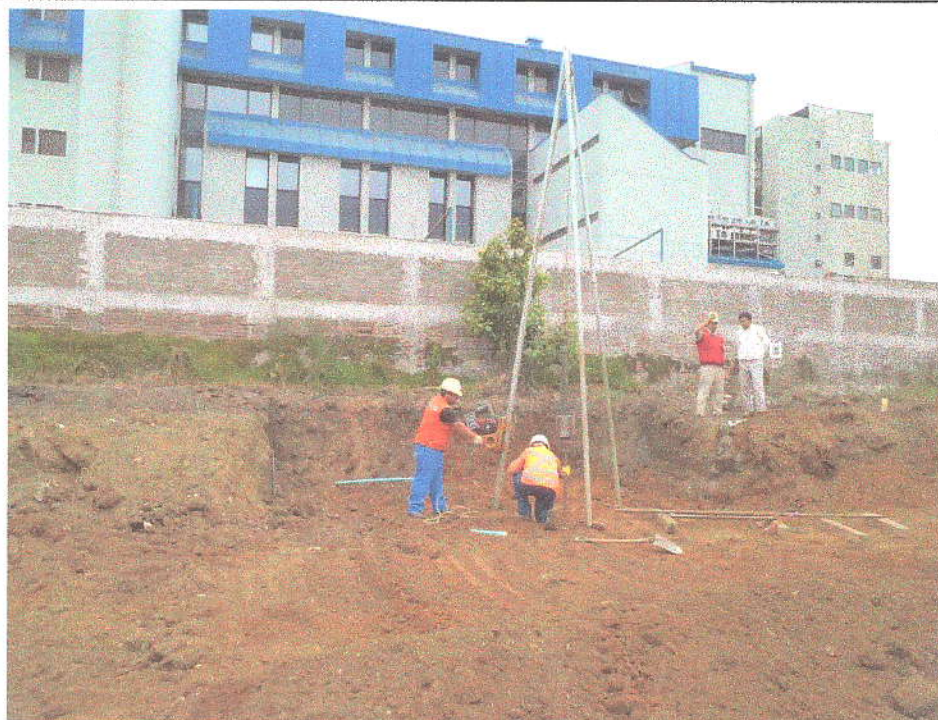
FOTOGRAFIA 13: EJECUCIÓN DE SONDAJE N°3
